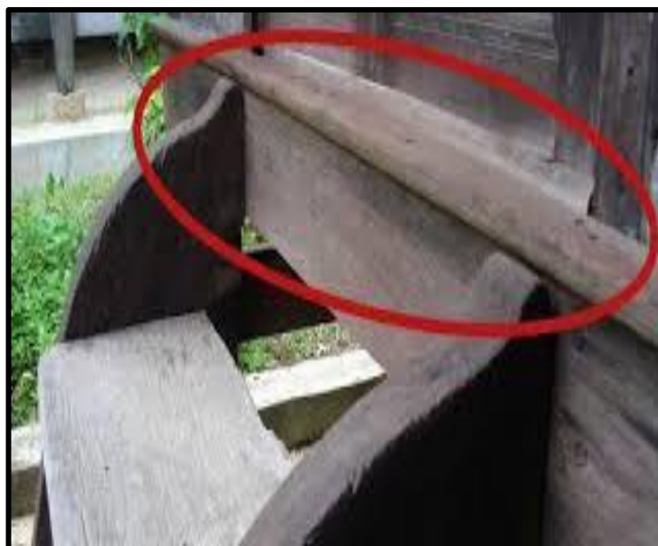
Rajah 6 Reka bentuk bendul yang dipasang pada rumah Melayu tradisional
