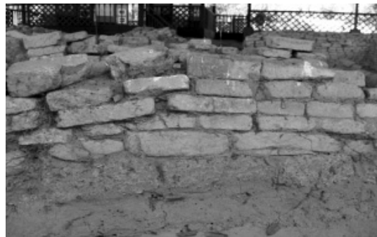
Foto 7. Batu laterit dan batu sabak yang digunakan sebagai asas struktur binaan
