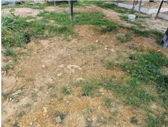
Q8-Tanah tidak porous, terdapat kesan takungan air
